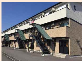
新設した外国人専用の寮 (外観)
