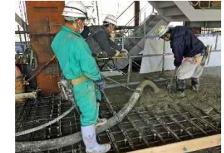
【圧送ポンプを利用して型枠内にコンクリートを打ち込むところ】
