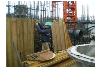
【コンクリートを流し込むための型枠を組む作業の様子】
