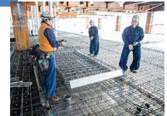
【鋼製型枠を鉄筋上に取付けている作業風景（左が外国人材）】
