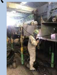
溶接作業の様子
